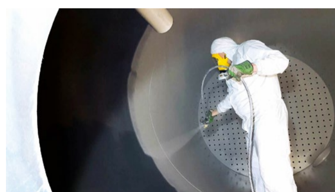
Die Beschichtung lässt sich im Airless-Spritzverfahren applizieren und weist eine hohe Abriebfestigkeit auf.
